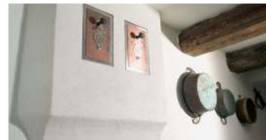
Ispezione canne fumarie in coordinato Coordinated inspection of chimney flues
